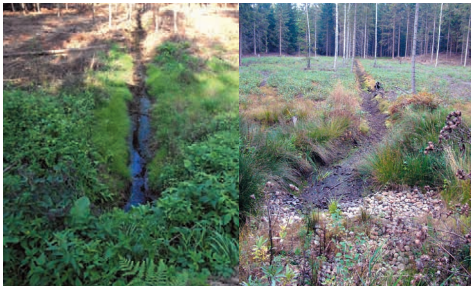
Fot. 30a i 30b. Odpływ z rezerwatu w 2012 r.(a) i zanik odpływu (b) rowem z południowej części rezerwatu w październiku 2014 r. (fot. Paweł Burandt).
