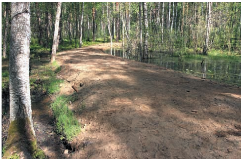
Fot. 26. Widok na groblę po usunięciu rury. Widoczne wyraźne spiętrzenie wody powyżej grobli tj. od strony torfowiska Sołtysek (maj 2013)
