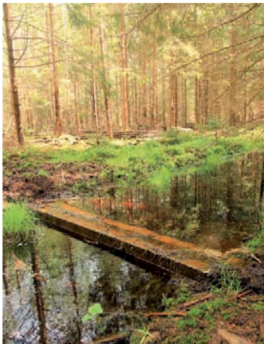
Fot. 23-24. Zastawka (u góry) i próg piętrzący (u dołu) w rezerwacie „Gązwa” (fot. Sebastian Menderski).
