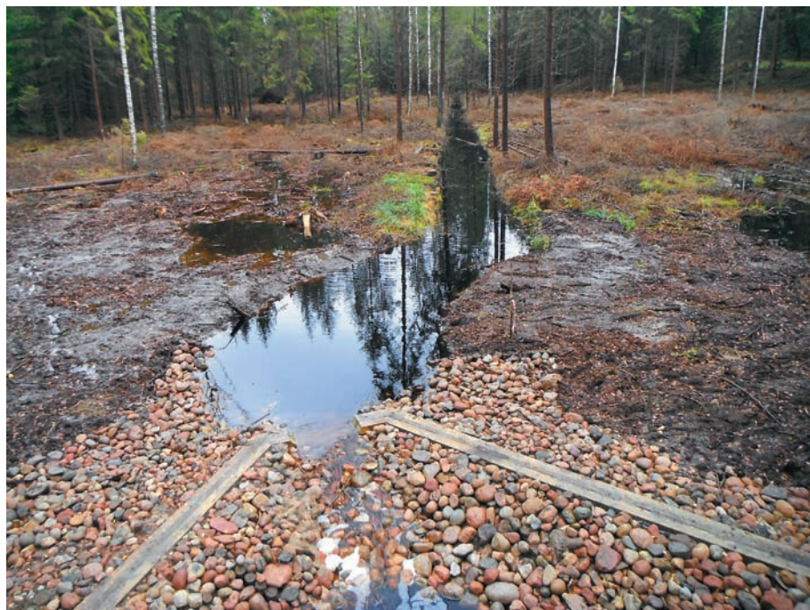
Fot. 29. Odpływ z południowej części rezerwatu przekrój pomiarowy Q8 w miejscu proggu piętrzącego nr 17 (patrz rys. 13) (fot. Paweł Burandt) .
