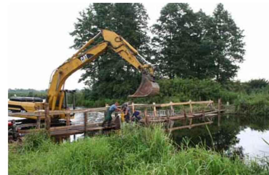
Budowa pierwszego progu na Narwi w roku 2007, fot. Arkadiusz Gorczewski
