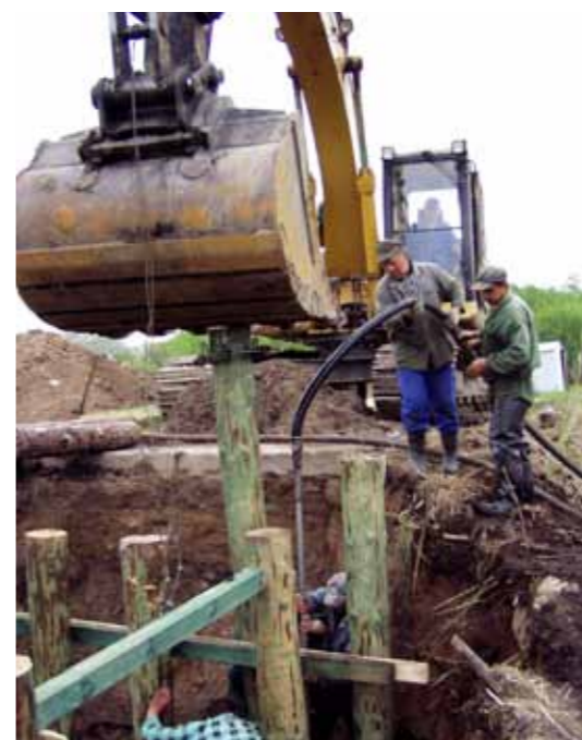
Budowa jednego z mostków na grobli Rzędziany-Pańki w 2003 roku, fot. Dariusz Ochrymiuk
