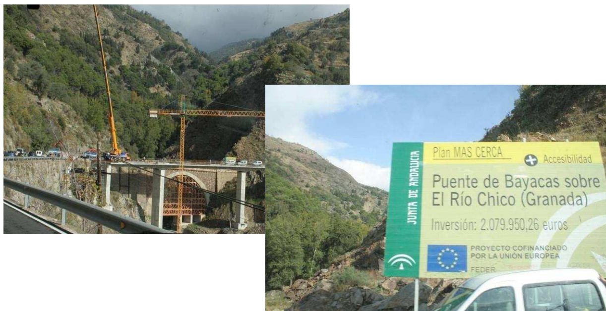
Ryc.15. Realizacja inwestycji mostowej ze środków UE w sąsiedztwie obszaru Natura 2000 – Sierra Nevada [źródło własne]
