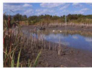
Spuszczanie wody ze stawu, przewidzianego do likwidacji
