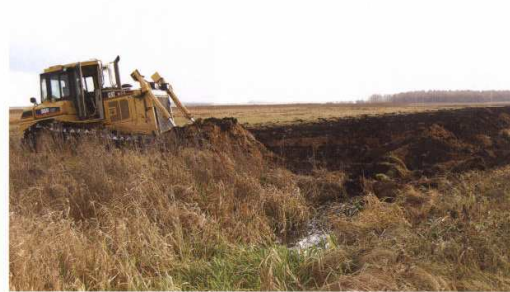
Zasypywanie rowów melioracyjnych. Fot. Marta Potocka
