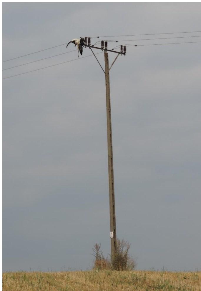
Fot. 1. Słup linii SN z porażonym prądem młodym bocianem
