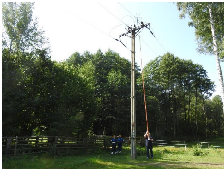
Fot. 5. Montaż urządzenia z ziemi bez wyłączenia linii za pomocą drążka izolacyjnego teleskopowego
