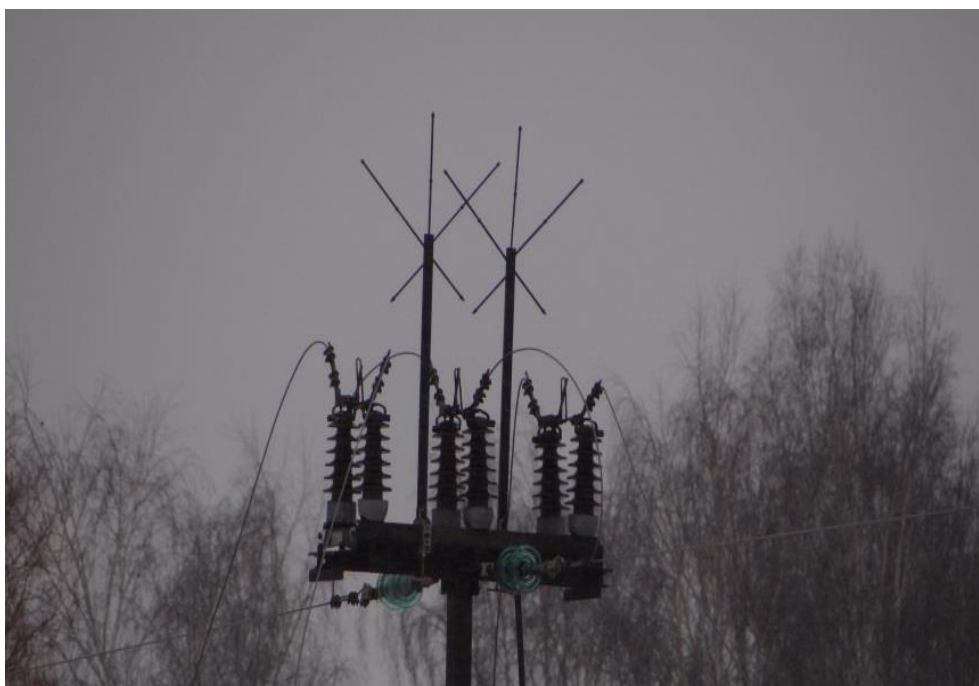
Fot. 4. Urządzenie skonstruowane przez specjalistów z branży elektroenergetycznej we współpracy z ornitologami swym kształtem nawiązuje do krzyża św. Andrzeja. Okazało się, że to bardzo skuteczne rozwiązanie całkowicie eliminujące śmiertelne porażania prądem bocianów
