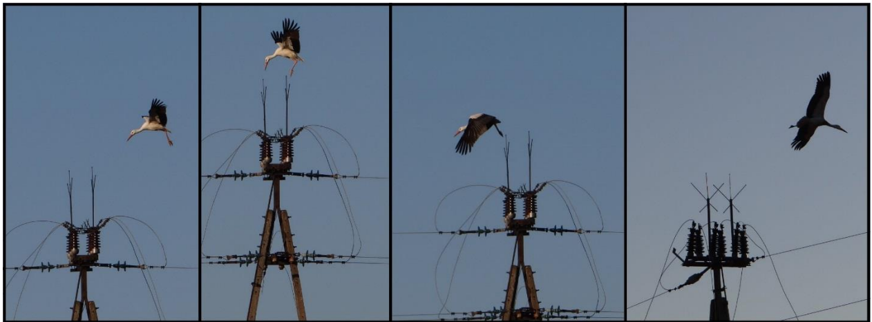
Fot. 6. Próba wylądowania młodego bociana na słupie SN z przewodami nieizolowanymi, która gdyby nie separator zakończyłaby się śmiercią ptaka (K. Piwowarczyk)
